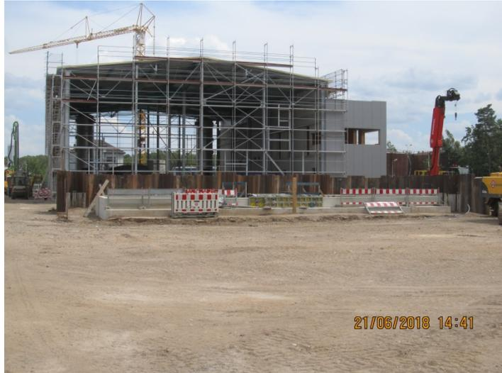
Nach Fertigstellung der Betonarbeiten am Annahmehunker und Regenrückhaltebecken wurden die Spundwände des Baugrubenverbau wieder entfernt. Die beiden obigen Bilder stellen den gegenwärtig aktuellen Stand der Bauarbeiten dar. In der nächsten Zeit werden sich die Arbeiten vor allem auf die Montage der maschinen- und elektrotechnischen Ausrüstung, die Fertigstellung der Halle, die Außenanlagen mit unterirdischer Verrohrung und die Anbindung an das MKW konzentrieren.
