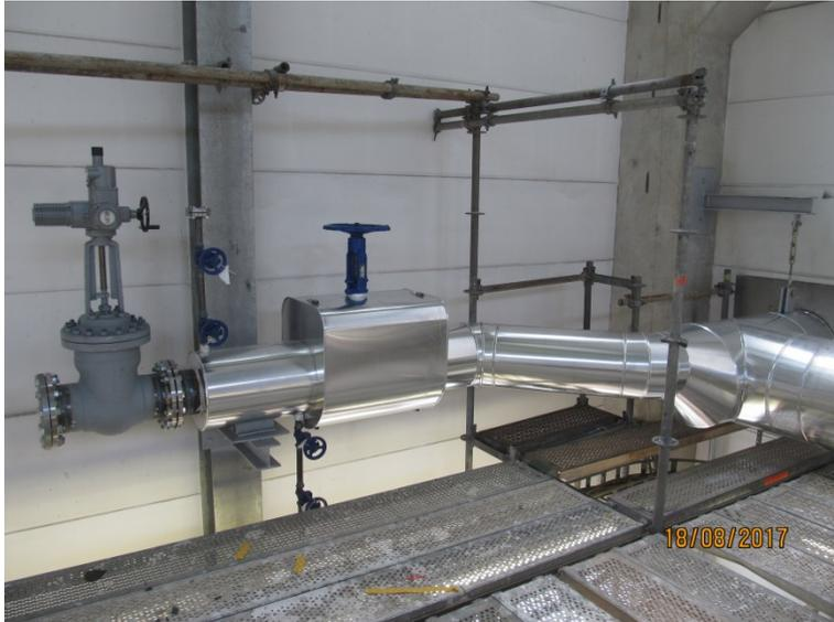
Ebenfalls im Sommer 2017 wurde der Anschluss an eine 6 bar-Dampfleitung im Turbinenhaus 5 des MKWs erstellt, da die betreffende Dampfleitung revisionsbedingt außer Betrieb und damit überhaupt erst zugänglich war.
