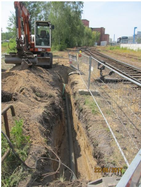
Vorbereitend auf den eigentlichen Bau der Klärschlamm-trocknungsanlage wurde im Sommer 2017 bereits ein Teil der Abwasserdruckleitung verlegt, durch welche später das anfallende Brüdenkondensat aus der Anlage zur Verbandskläranlage Schwandorf-Wackersdorf abgeleitet werden soll. Nachdem im betreffenden Bereich teilweise auch Arbeiten an der Gleisbeleuchtung erfolgten, konnten die Arbeiten gemeinsam ausgeführt und gewisse Synergien erreicht werden.
