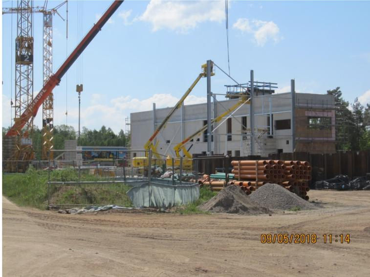
Die ersten Stützen der Trocknerhalle werden montiert. Im Hintergrund der Anbau der Halle, hier ist der Rohbau zu großen Teilen fertiggestellt.
