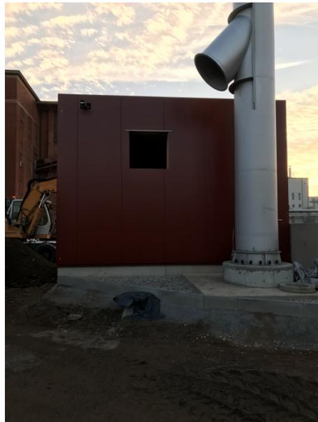
An der Pumpstation, in der die Pumpen für Ab- und Regenwasser untergebracht sind, und der Abluftstation, worin später das Saugzuggebläse für die Förderung der Abluft durch den Biofilter in Richtung Kamin stehen soll, wurde ebenfalls die Fassadenverkleidung angebracht.
