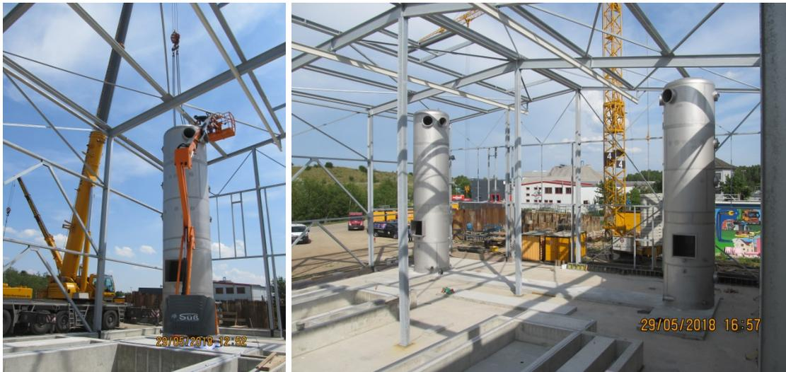
Die ersten Teile der Maschinenteknik, die beiden Sprühkondensatoren der zwei Trocknerlinien, konnten durch das noch offene Hallendach eingehoben und an ihrem späteren Standort platziert werden.
