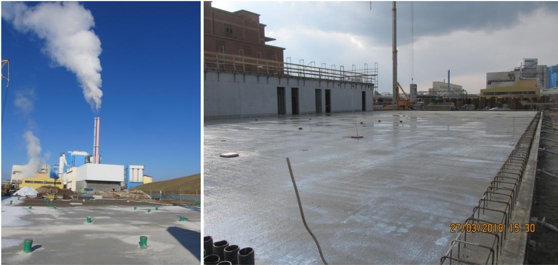
Parallel zu den Betonarbeiten am Anbau wurde bereits mit der Erstellung der Fundamente und der Bodenplatte der Trocknerhalle begonnen.
