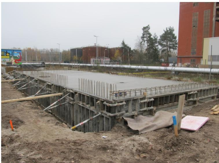
Im ersten Bauabschnitt wurden die Fundamentierung und die Bodenplatte des Anbaus der Trocknerhalle errichtet. In diesem Gebäude werden später u.a. die elektro- und leittechnische Ausrüstung, Lagerräume, Sanitäranlagen und eine Leitwarte untergebracht sein.
