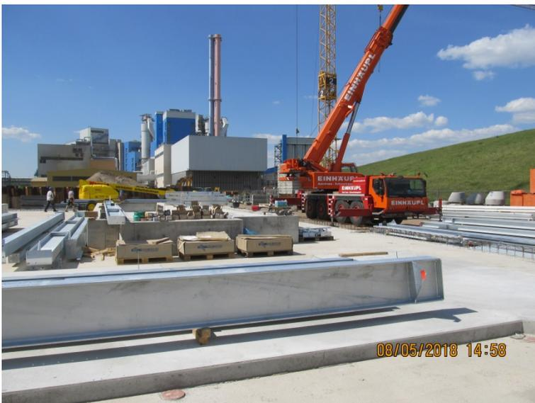
Anfang Mai diesen Jahres wurden die Stahlteile der Trocknerhalle geliefert. Mit der Montage der Halle wurde gleich im Anschluss begonnen.
