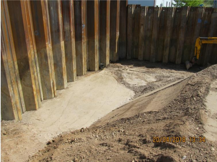
Nach Fertigstellung der Spundwände erfolgte der Aushub der Baugruben. Währenddessen hatten auch am Biofilter die Arbeiten bereits einen deutlich erkennbaren Fortschritt erreicht.
