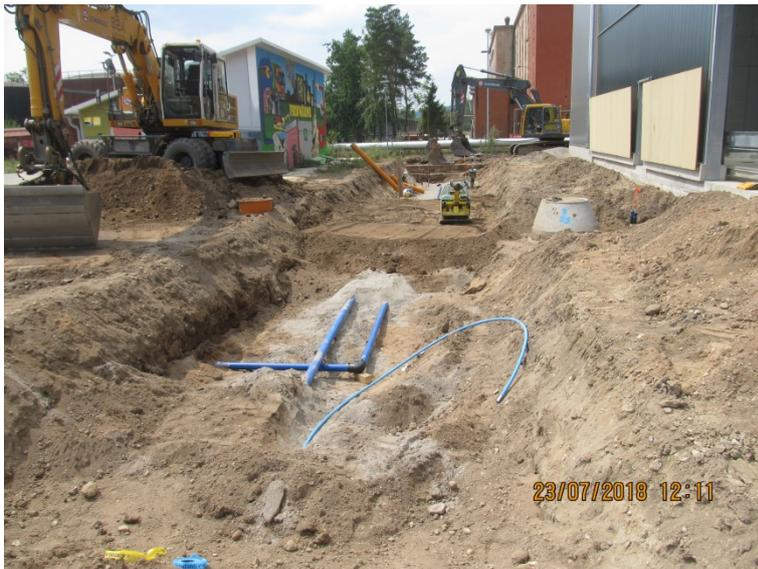
In den Außenbereichen rund um die Trocknerhalle und den Anbau wurden zahlreiche Rohrleitungen, Schächte, Kabel usw. verlegt bzw. verbaut. Hierdurch wird z.B. die Versorgung der Anlage mit Trink- und Brauchwasser gesichert, anfallendes Regen- und Abwasser abgeleitet und außenliegende Anlagenteile elektrisch angebunden.
