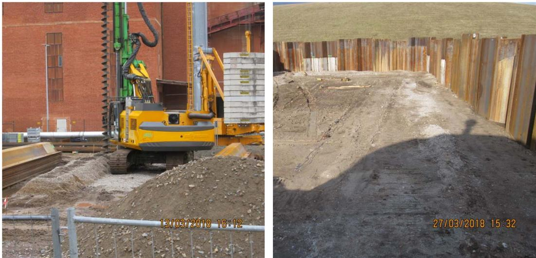
Nachdem die Sohlentiefe der Baugruben von Annahmehunker und Regenrückhaltebecken unterhalb des Grundwasserspiegels lag, war es erforderlich, die Gruben vor eindringendem Grundwasser zu schützen. Dazu wurden mit einer Ramme zunächst Vorbohrungen in das Erdreich eingebracht und anschließend Spundwände bis zur grundwasserstauenden Tonschicht eingeschlagen und abgedichtet.
