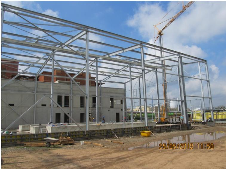
Etwa zwei Wochen dauerte die Montage des Stahlbaus der Trocknerhalle. Schon vor dem Hallengerüst waren die Fundamente, auf denen später die Trockner stehen werden, fertiggestellt worden.
